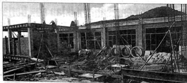
PROSES: Kondisi terkini pembangunan gedung asrama baru Thawalib Padangpanjang.
